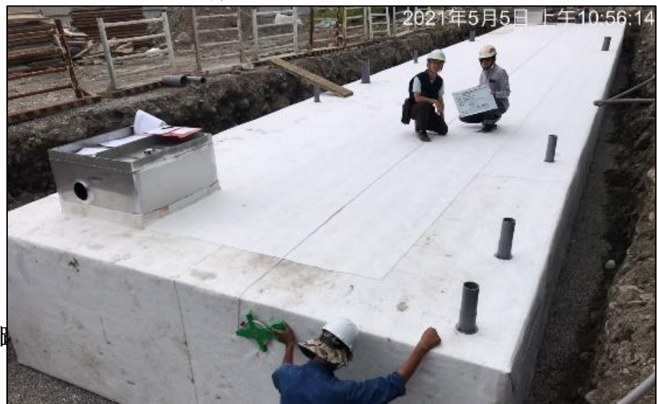
圖二十一、有機農業研究中心雨水積磚(水撲滿)施作
