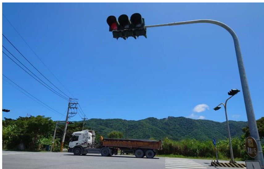
圖二十七、台 11 丙 與花 35 交叉路口由閃黃燈變為常駐紅綠燈
