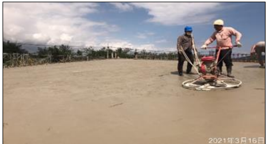
圖三十二、二樓斜屋頂頂板混凝土初凝進行整體粉光避免龜裂
