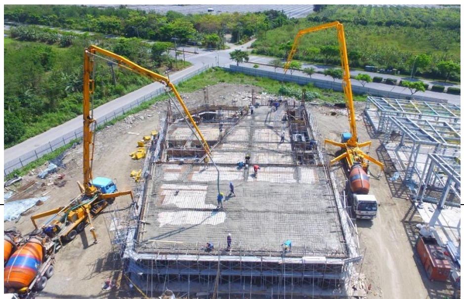
圖三十、主棟1樓混凝土澆置(模板設置分層澆置口)
