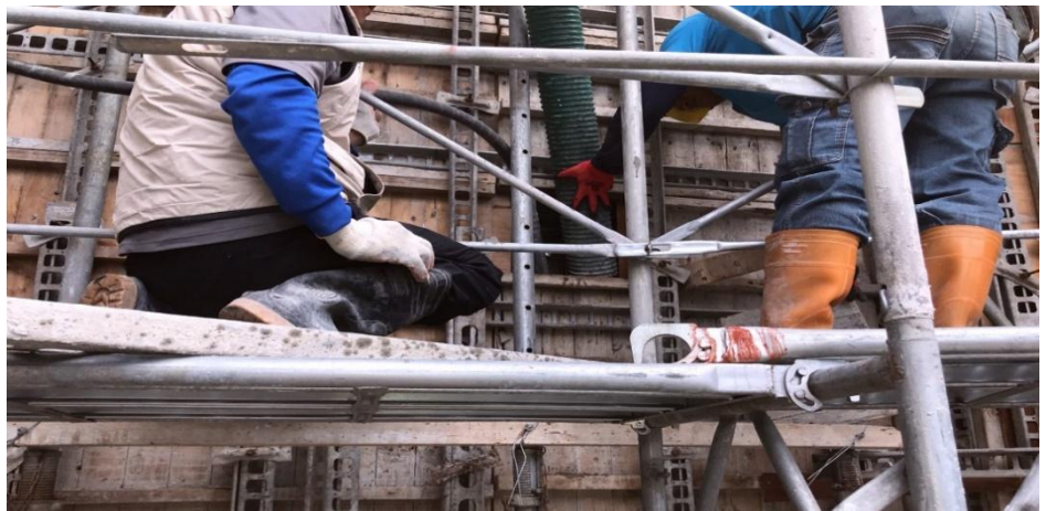
圖三十、主棟1樓混凝土澆置(模板設置分層澆置口)
